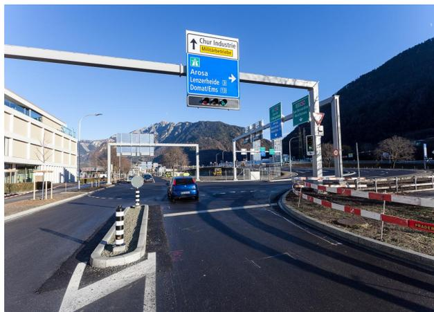
Mit dem Umbau des Anschlusses Chur Süd wurden auch die angrenzenden städtischen Knoten angepasst. Am Knoten Sommerausstrasse/Spundisstrasse wurde zudem eine Lichtsignalanlage installiert. Emch+Berger hat die neue Lichtsignalanlage projektiert und deren Realisierung begleitet. Ausserdem wurden die Verkehrsmengen als Basis für die Steuerung abgeschätzt.
